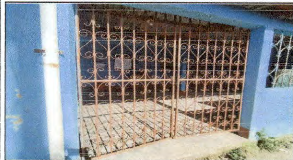
Sustitución de portón de metal
